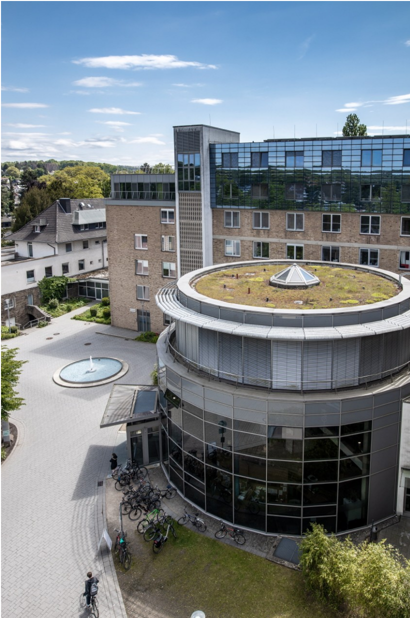
Haupteingang des Evangelischen Krankenhaus Bergisch Gladbach
